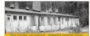
Abriss Ferienlager „Karl Liebknecht“ Pädagogische Hochschule Potsdam
